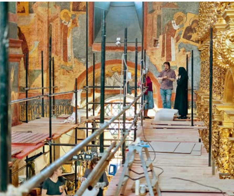
Реставрационные работы в Смоленском соборе (слева)
