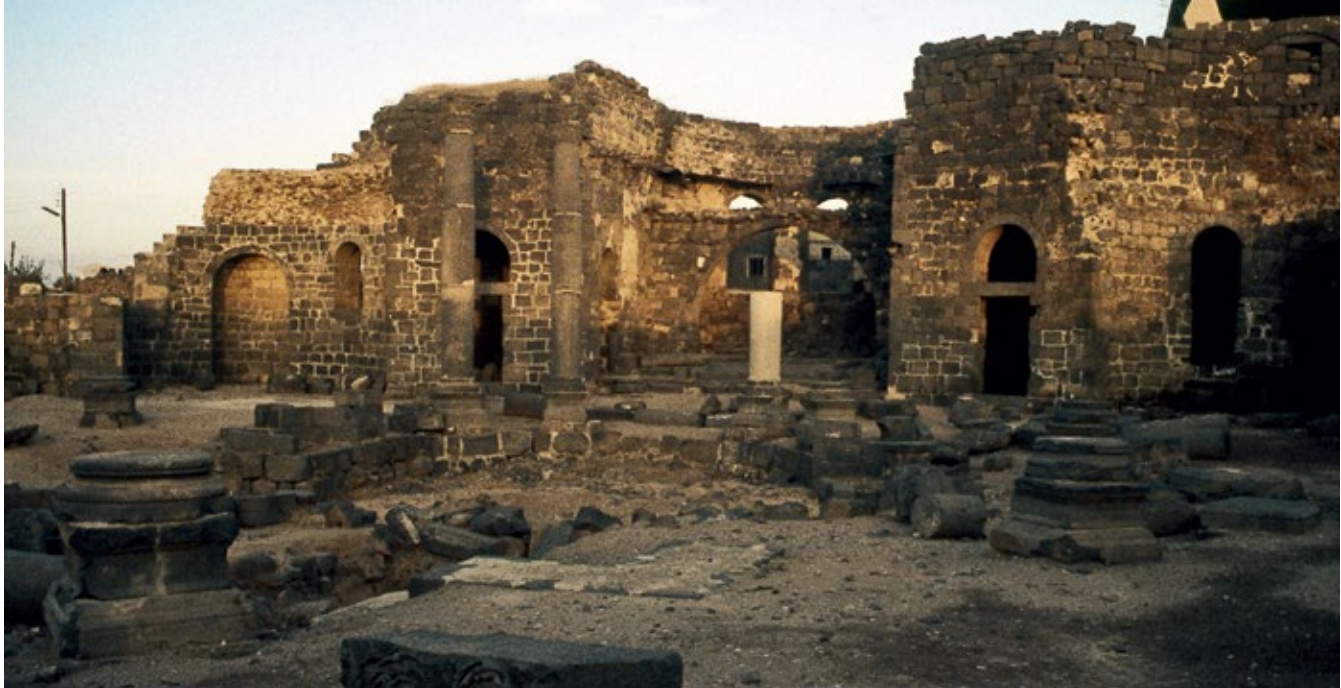
Собор Св. Сергия, Вакха и Леонтия в Босре. Строительство завершено в 512–513 гг.
