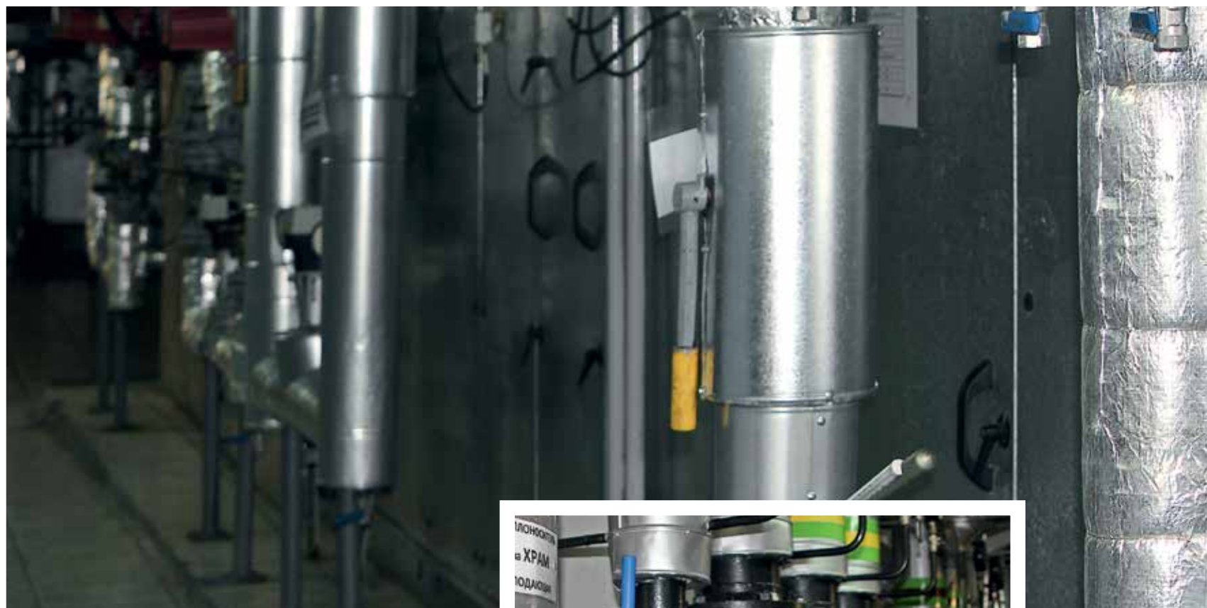
Начальник службы вентиляции Храма Христа Спасителя Сергей Белов демонстрирует кондиционеры под нижней Преображенской церковью. Это огромные установки, внутри — заборные клапаны, мембранные глушители, две секции фильтров и теплообменник. На выходе — две трубы с подготовленным воздухом
