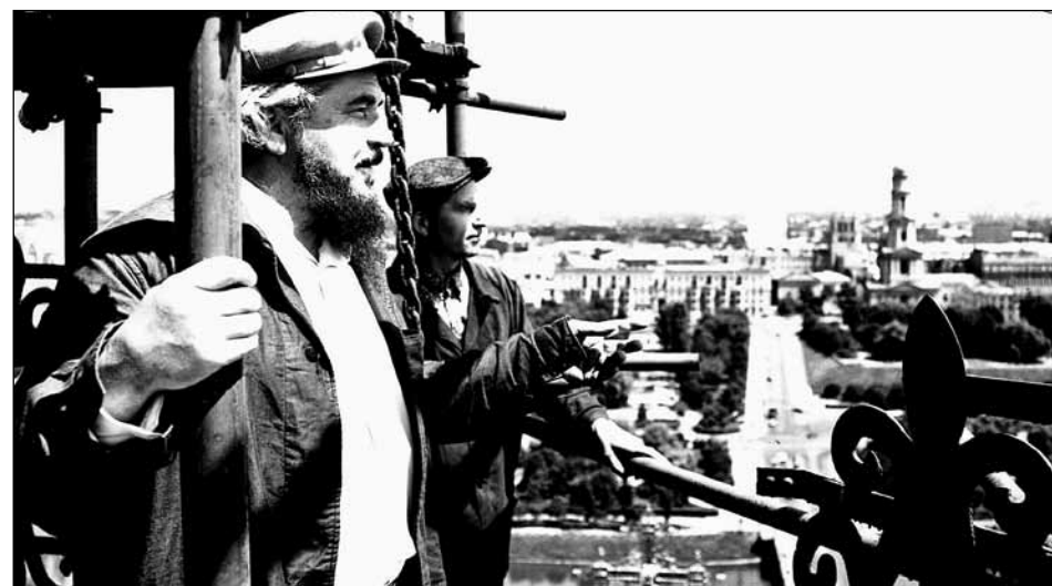
Кровельные работы в Свято-Благовещенском кафедральном соборе Буэнос-Айреса
