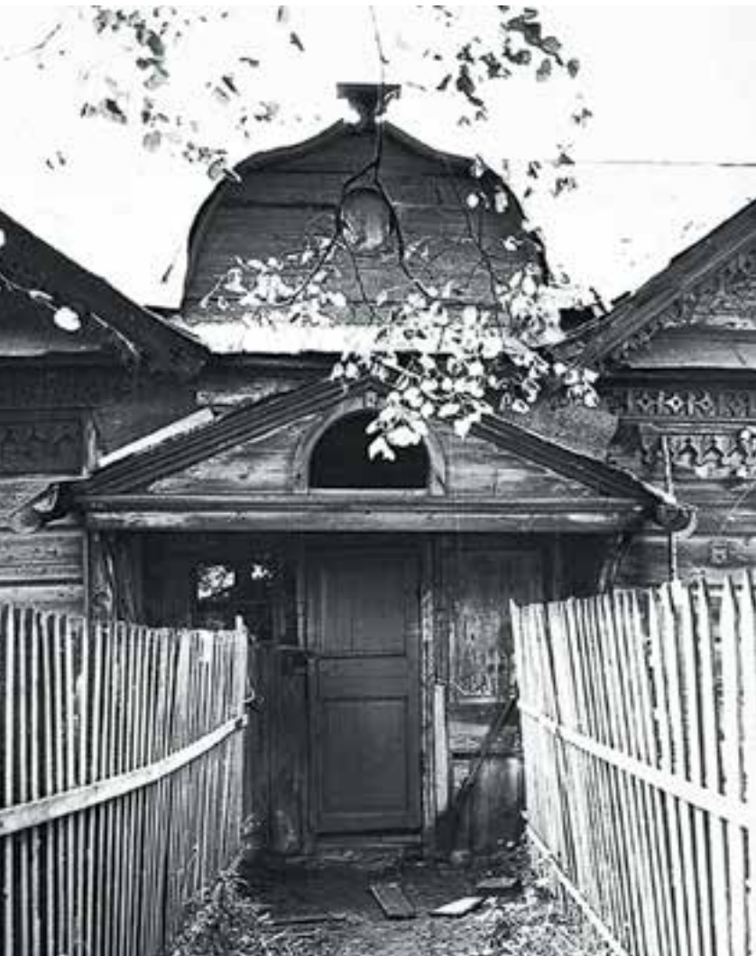
Южная угловая башня (вверху слева) Вид из-за пруда на келью северного комплекса скита (вверху справа) Вход в келью наместника (внизу)
