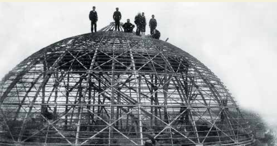
Металлическая конструкция главного купола
