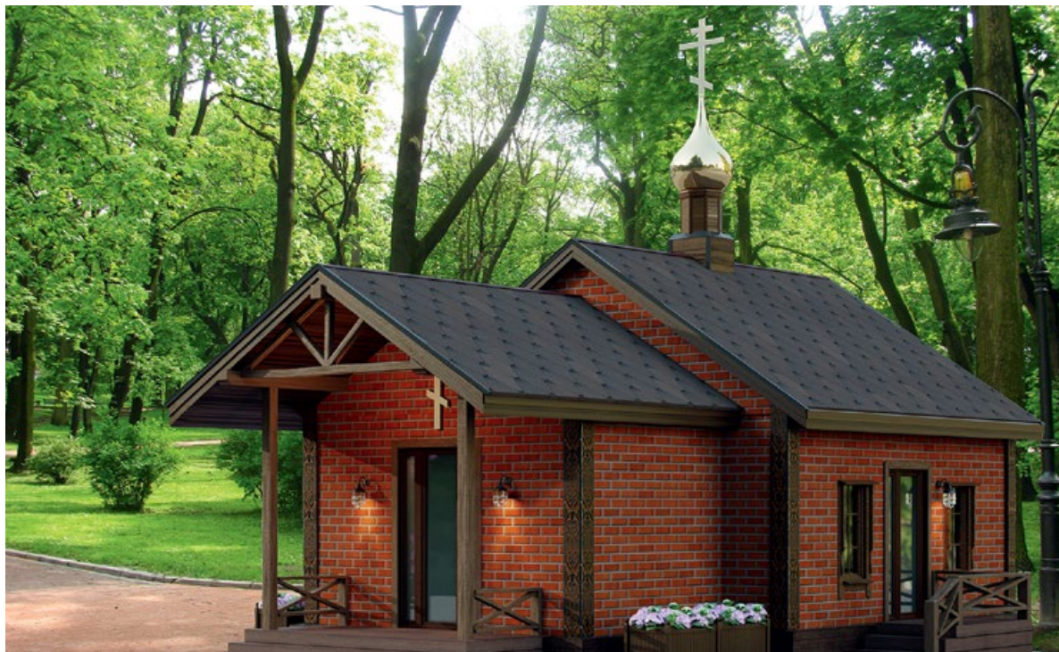
Вариант кирпичной отделки фасада
