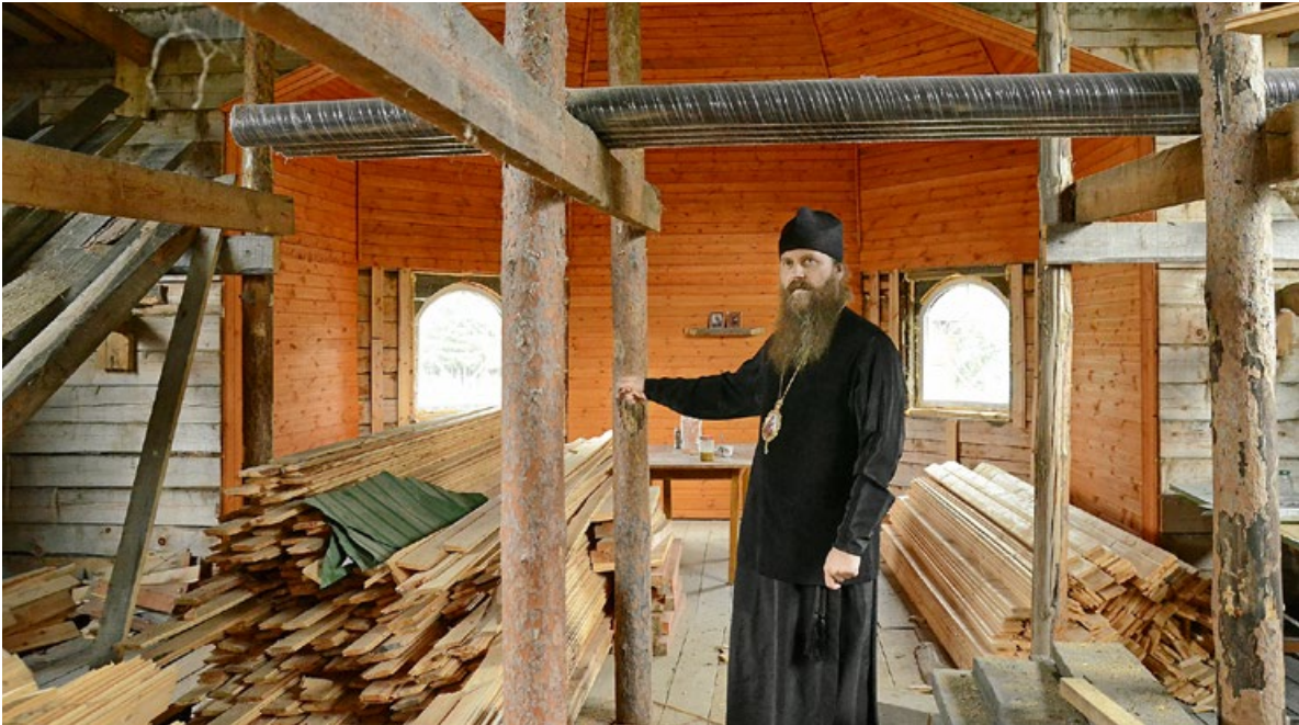
В строящемся храме в с. Красный Яр
