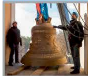
Подъем колокола 6500 килограмм на северную колокольню Александро-Невской Лавры
