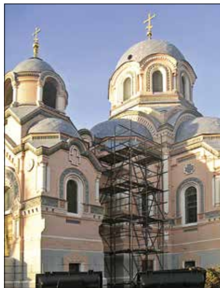
Ил. 6. Наземные прожектора заливающего освещения
