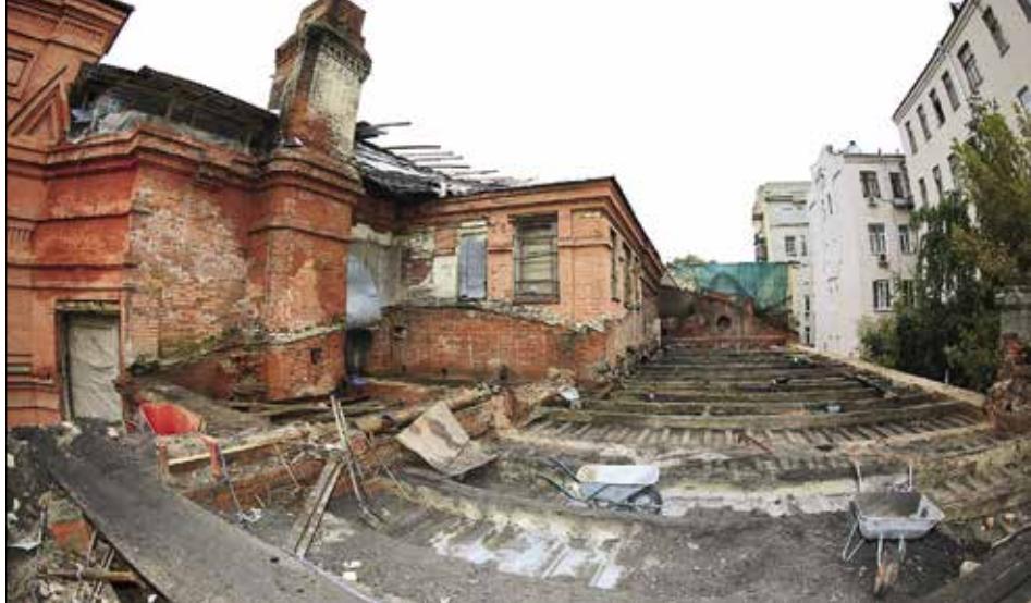
Перекрытие левого крыла до начала реставрации
