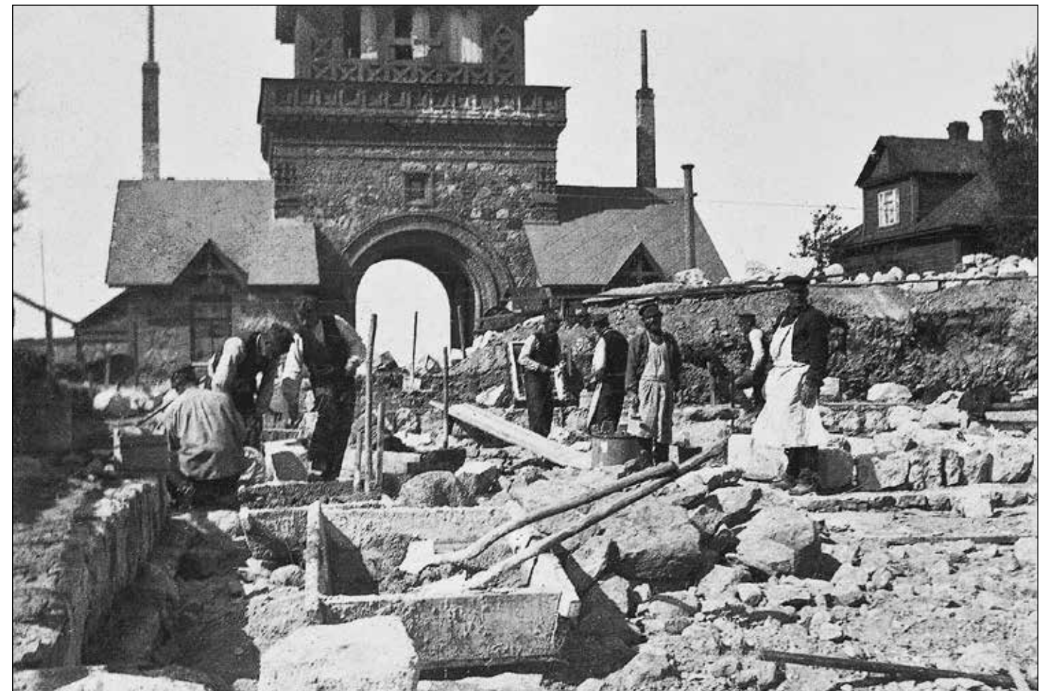
Строительные работы при сооружении Пюхтинского Успенского собора. 1908 г.
