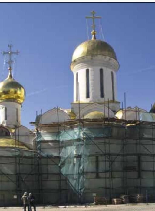
Троицкий собор (1422–1423). Отреставрированы фасады из облицованной белым камнем плинфы — тонкого наливного кирпича, ближайшего предка большемерных реставрационных кирпичей. Обновлена позолота на куполе и на куполах
