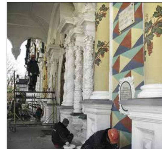
Трапезная церковь (1686–1692). Обновлены рассыпавшееся на части главное крыльцо, разрушавшееся гульбище над подклетом и парпет с единой линией балюса. Отреставрирован позолоченный барочный декор. Капитально отремонтированы фасады, для защиты от стекающих с крыши осадков устроен технический дренаж. В интерьерах обновлена масляная живопись
