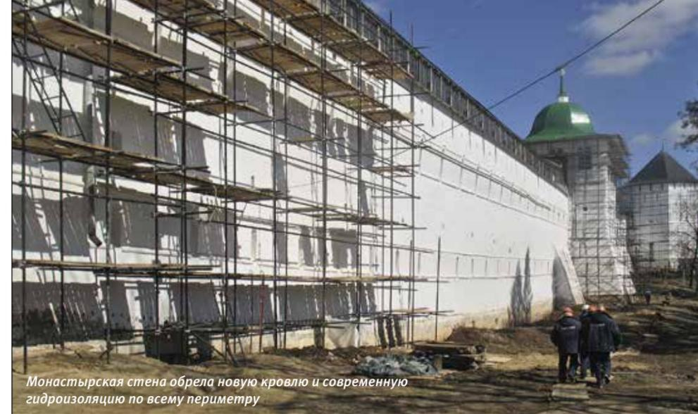
Монастырская стена обрела новую кровлю и современную гидроизоляцию по всему периметру
