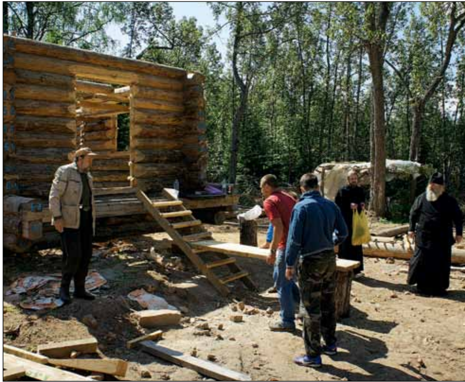
Строительство храма в с. Турилово
