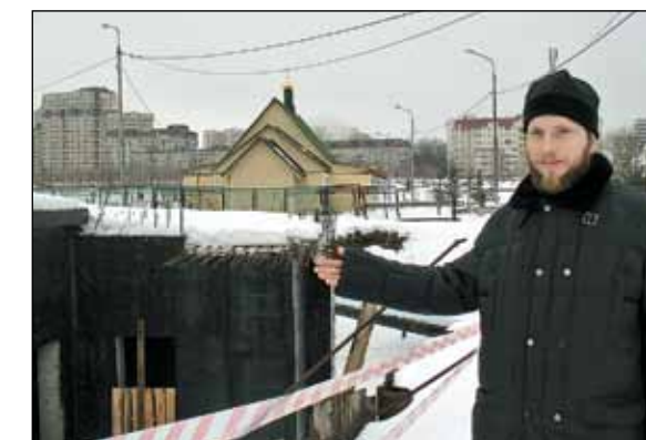
Люблино, котлован на стройплощадке Татианинского храма. Работы приостановлены, но священник Иоанн Коваль не унывает: временный храм-«конструктор» получился теплым и удобным
