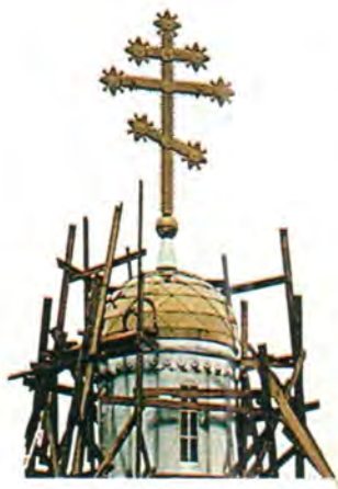
Установка креста на купол над главным корпусом семинарии
