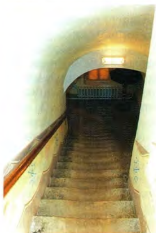
Лестница на второй этаж
