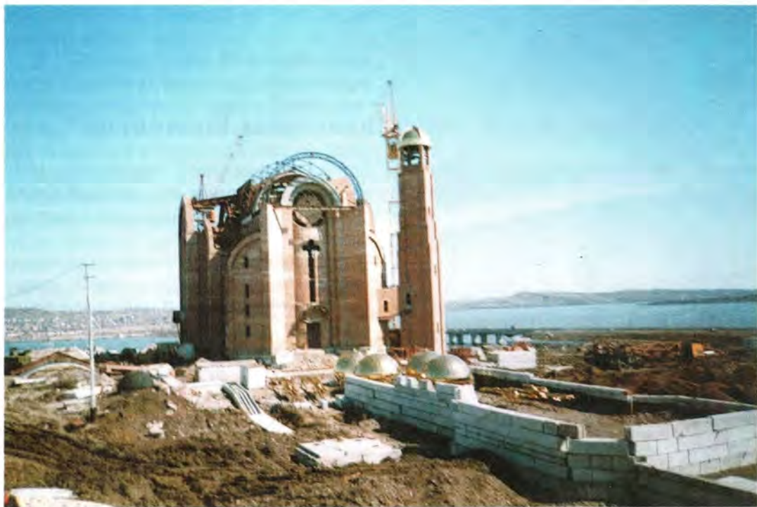
На одном из этапов строительства
