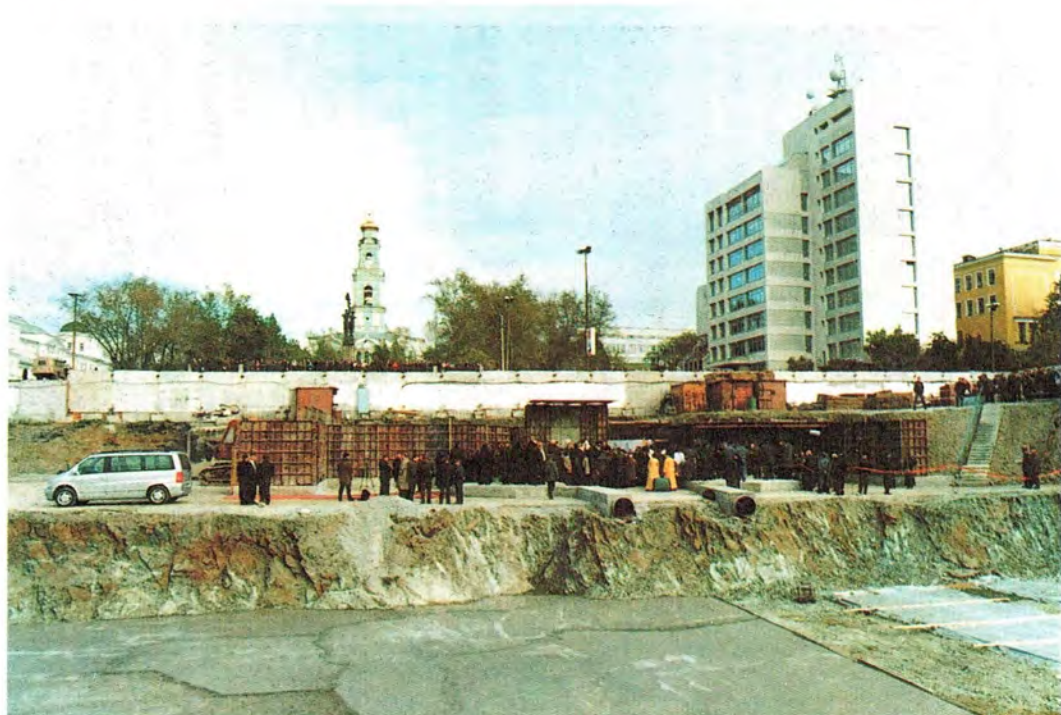
Общий вид места строительства храма-памятника на кровли
