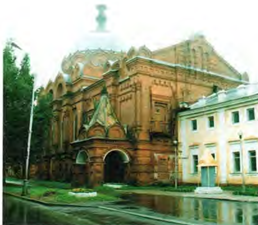
Здание бывшей Троицкой церкви в Сарове
