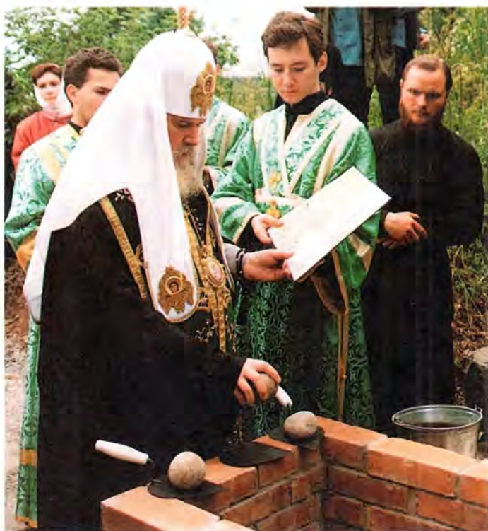
Закладка административного здания на Валааме. 10 июня 2000 года
