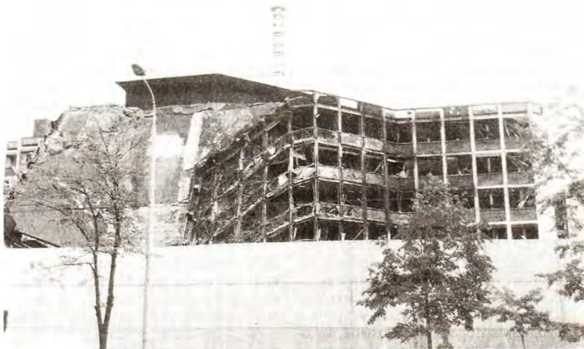
Разрушенное здание в Белграде
