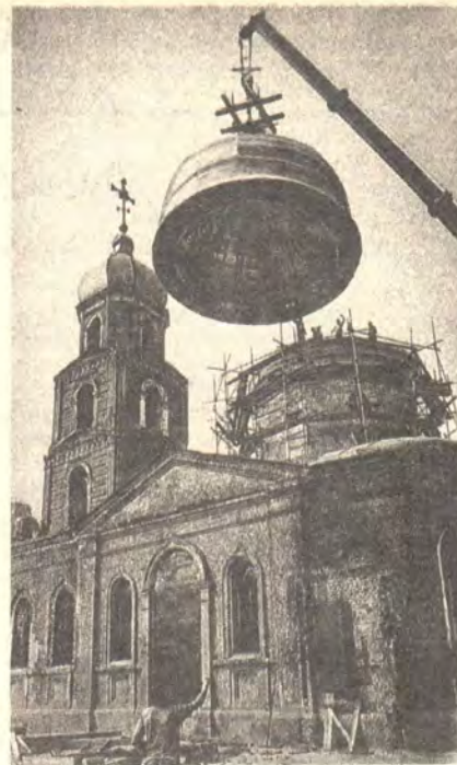
Установка купола Пантелеимоновского храма в Харькове, 17 августа 1990 года
