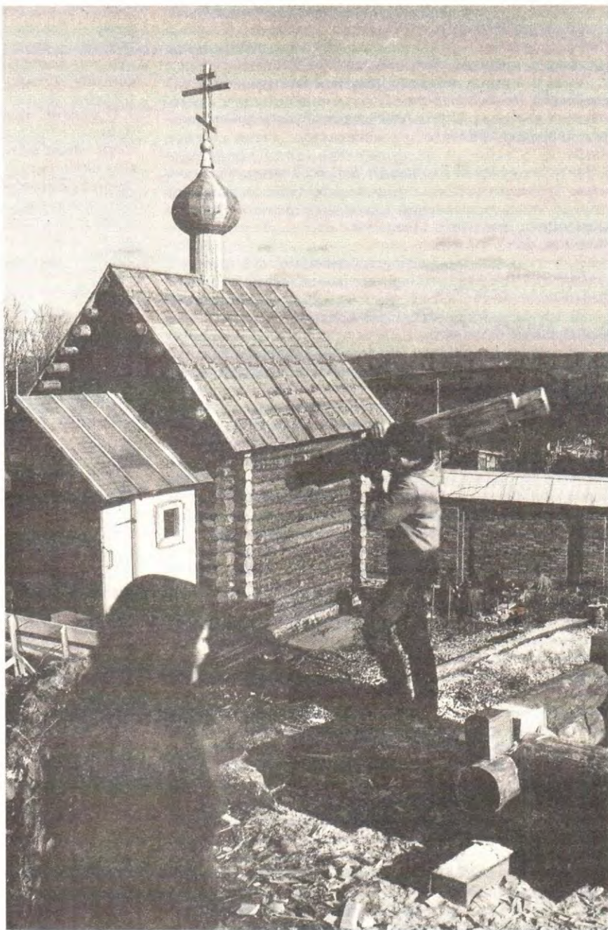
Строительство часовни над Трифоновским источником
