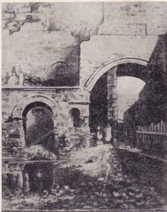
РАСКОПКИ (1858 года) ОКОЛО АРКИ «СЕ ЧЕЛОВЕК» С ЗАПАДНОЙ СТОРОНЫ — ЦЕНТРАЛЬНАЯ И ОДНА ИЗ БОКОВЫХ АРОК ТРИПИЛОНА ИМП. АДРИАНА
